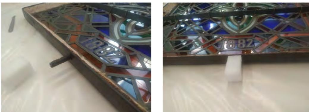
*Imagen 25. Colocación de la espuma de polietileno en los tornillos de sujeción. Fotografía: Lucía Ponce.*
